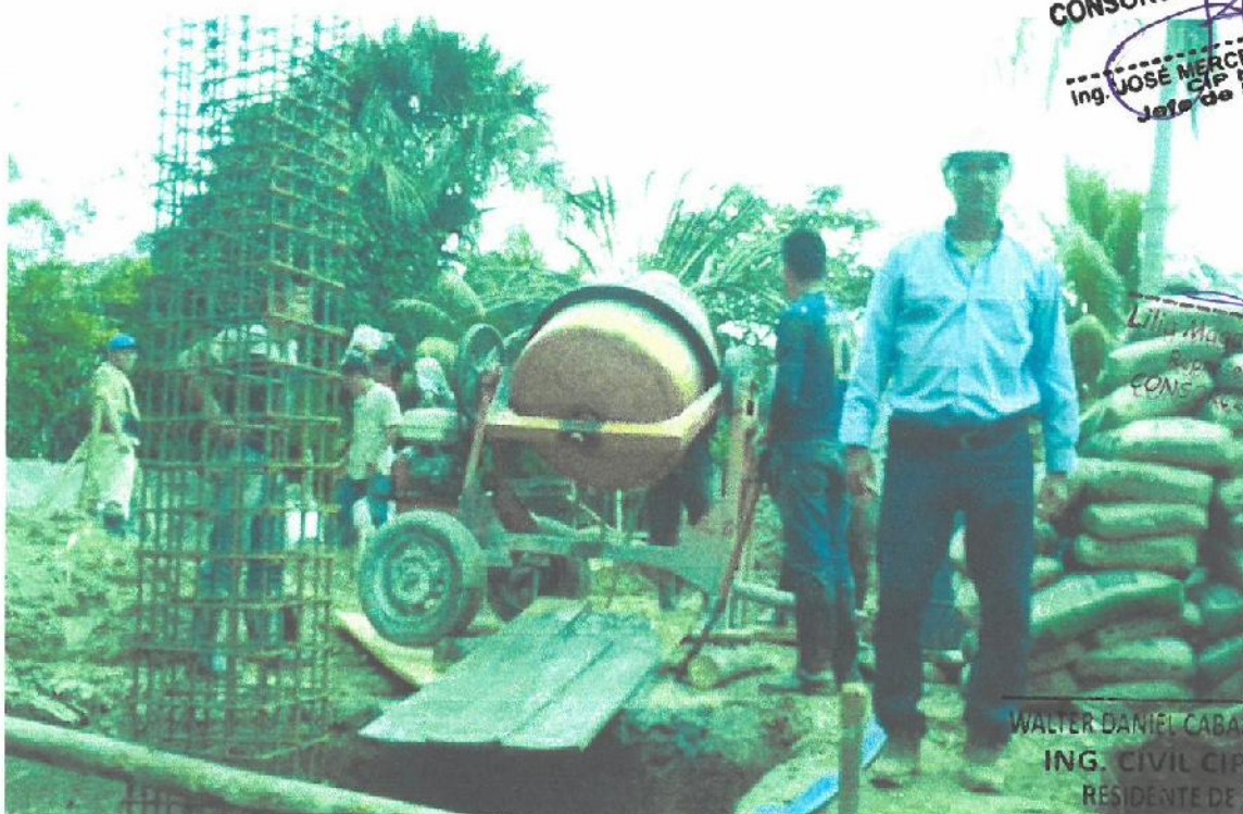
Imagen 12: verificando la instalación de la armadura de fierro para columnas puente proyectado y posterior vaceo
