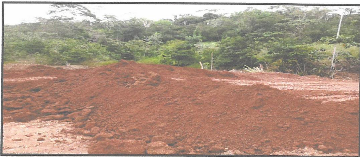
Imagen 23: Conformación de terraplenes.
