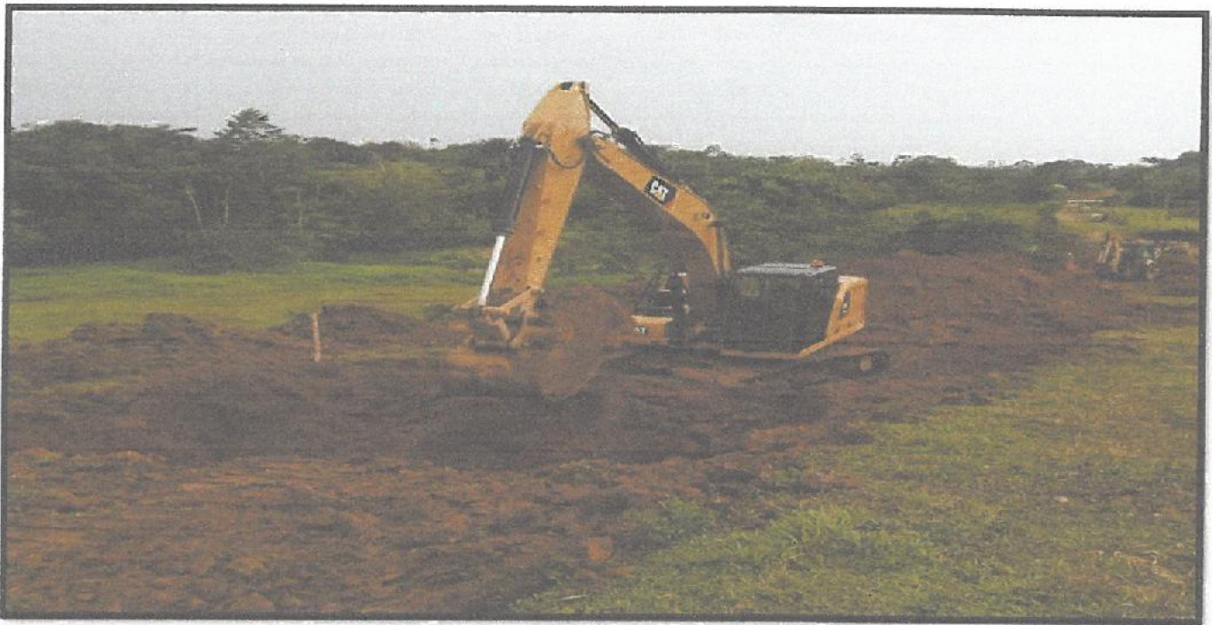
Imagen 19: Corte y Eliminación de cubierta vegetal mediante trabajos de maquinaria pesada (Excavadora 320 GC).
