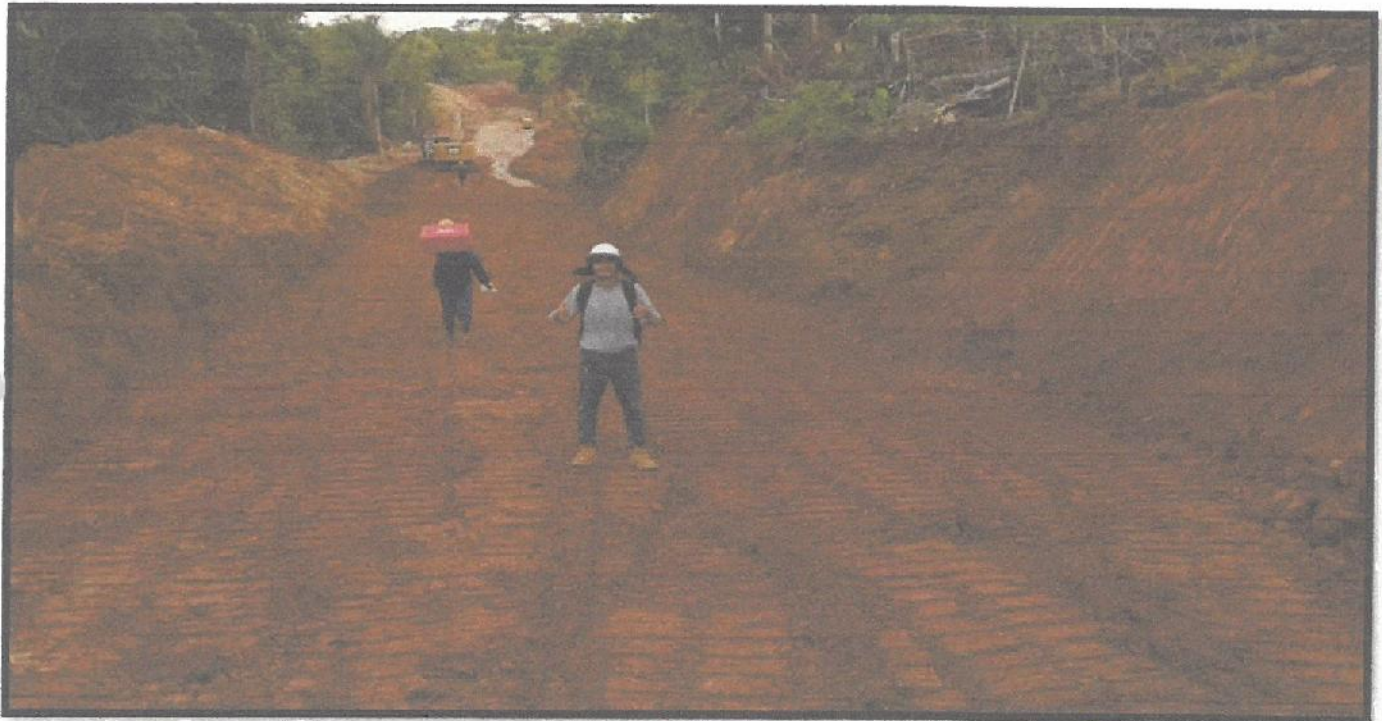
Imagen 22: Resultado del corte de terreno a nivel de subrasante.
