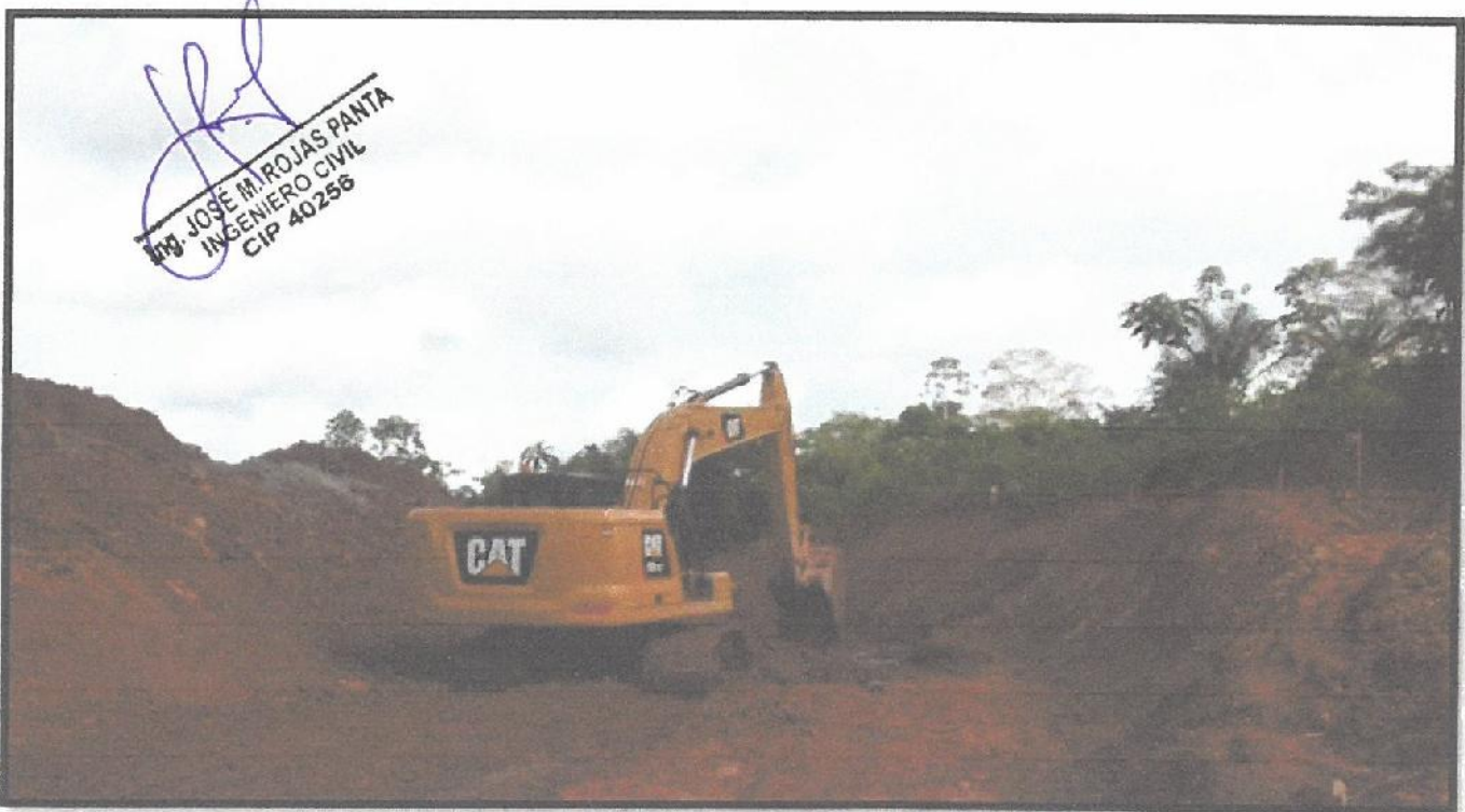
Imagen 20: Corte de Terreno mediante maquinaria pesada (Excavadora 320 GC).
