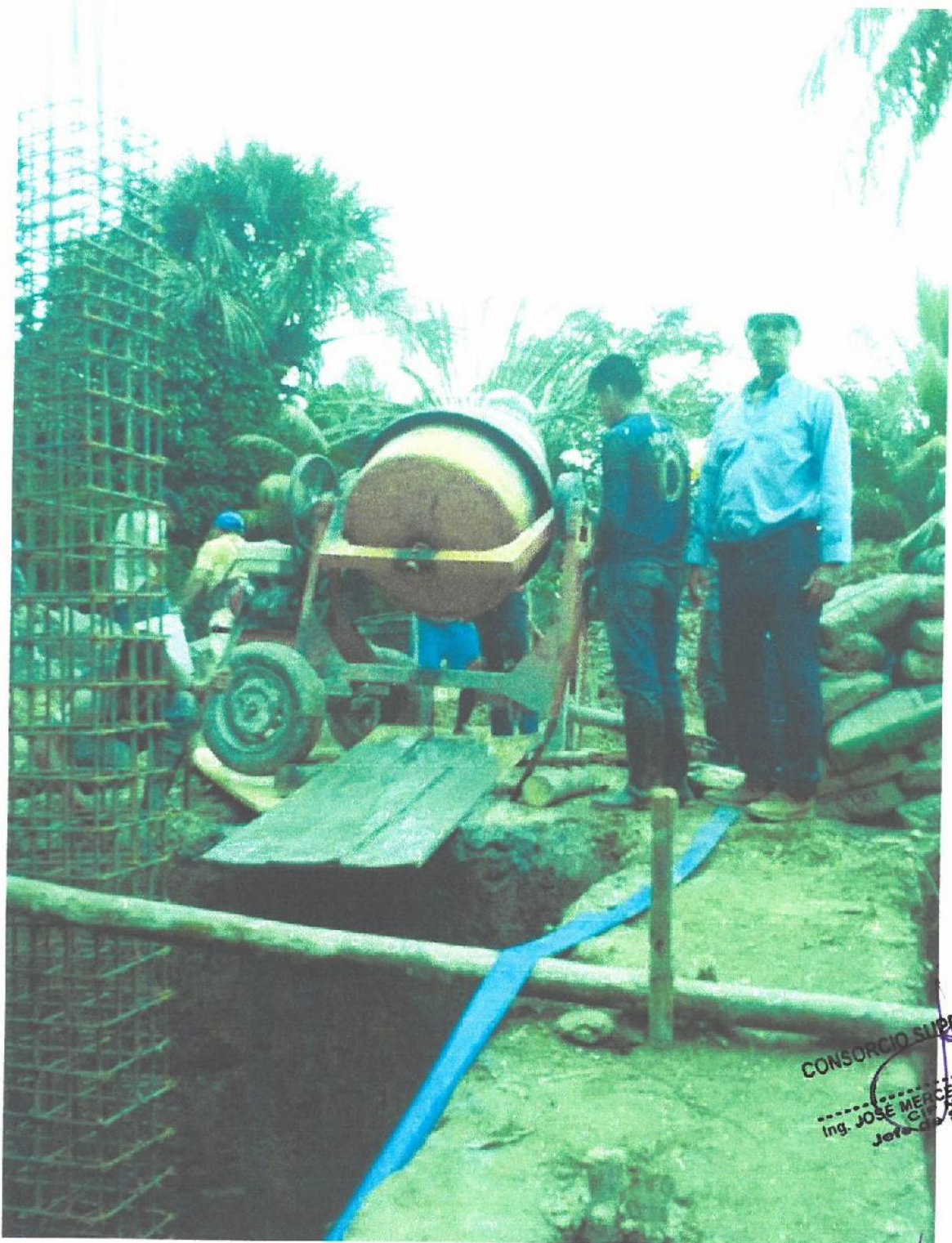
Imagen 14: Armadura de fierro de 5/8" colocada in situ listo para ser encofrado
