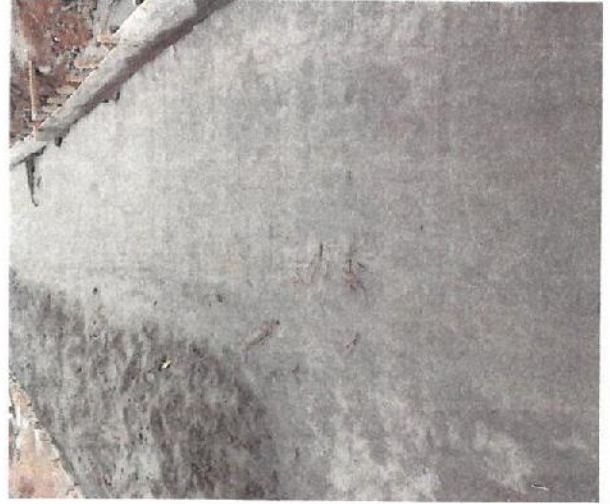
F.17 BASE DE MORTERO MEZCLA 1:8 = 0.10M PROGRESIVA 00+020-00+150
