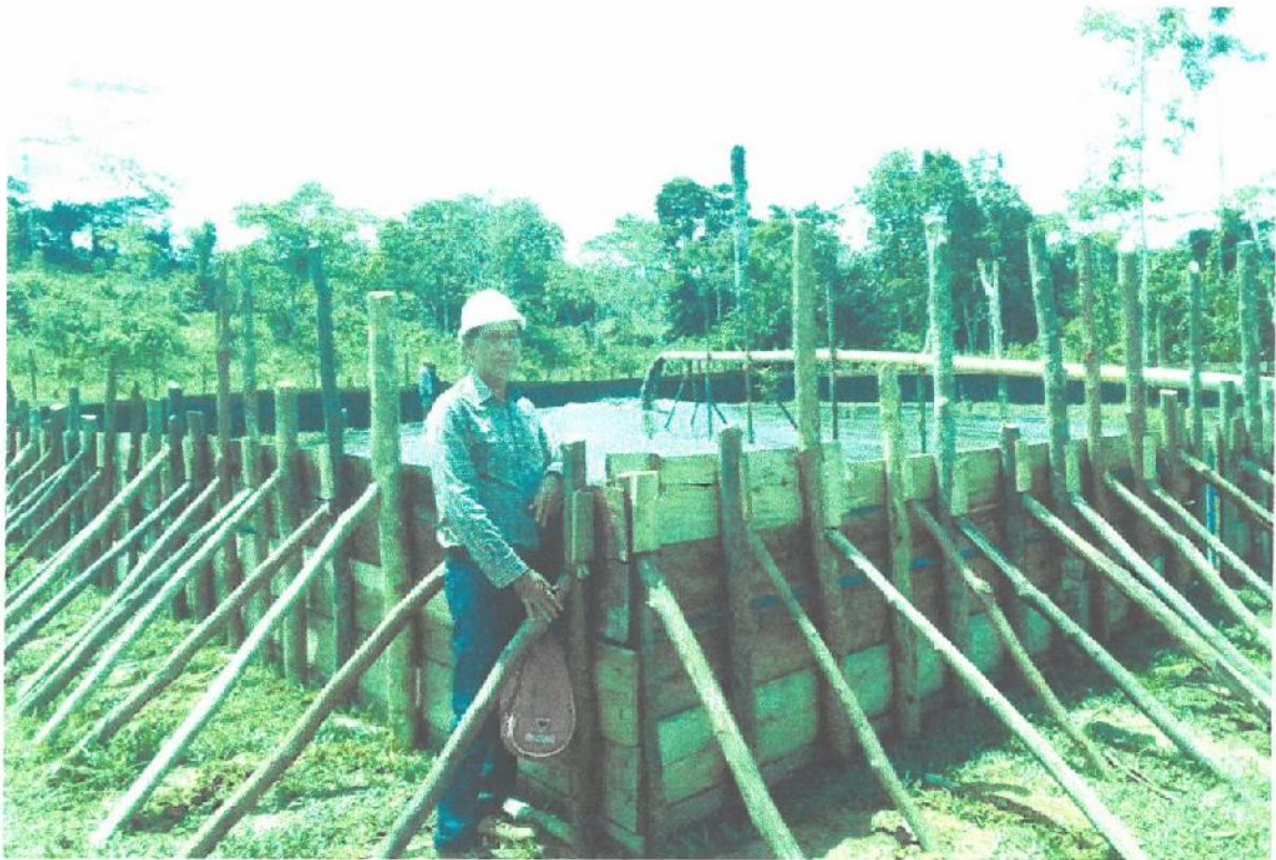
Imagen 11: Arena del rio puesto en obra
