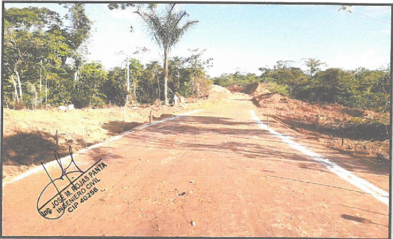
Imagen 16: Elaboración de Trazos para la medición del ancho y largo de la carretera a lo largo de las progresivas.
