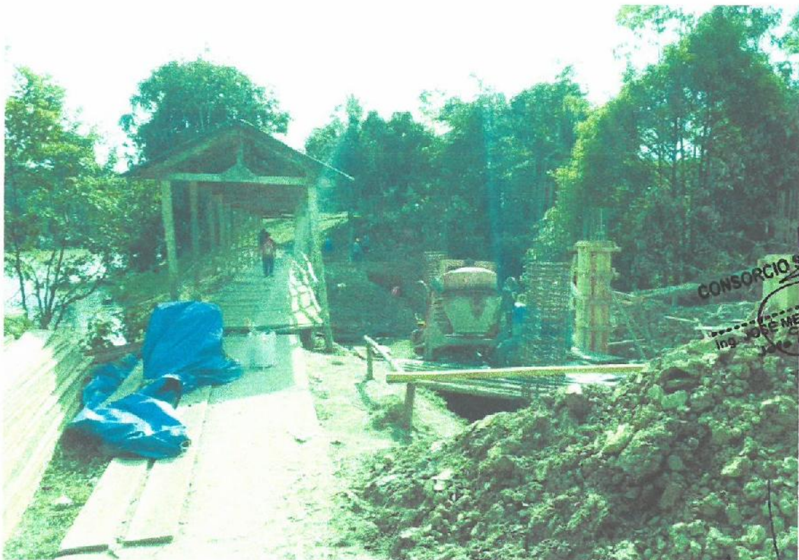
Imagen 9: vaceo de columnas puente proyectado0
