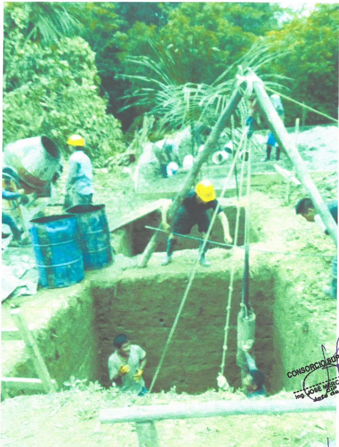
Imagen 10: Pilotaje con madera dura en zapatas del Puente proyectado
